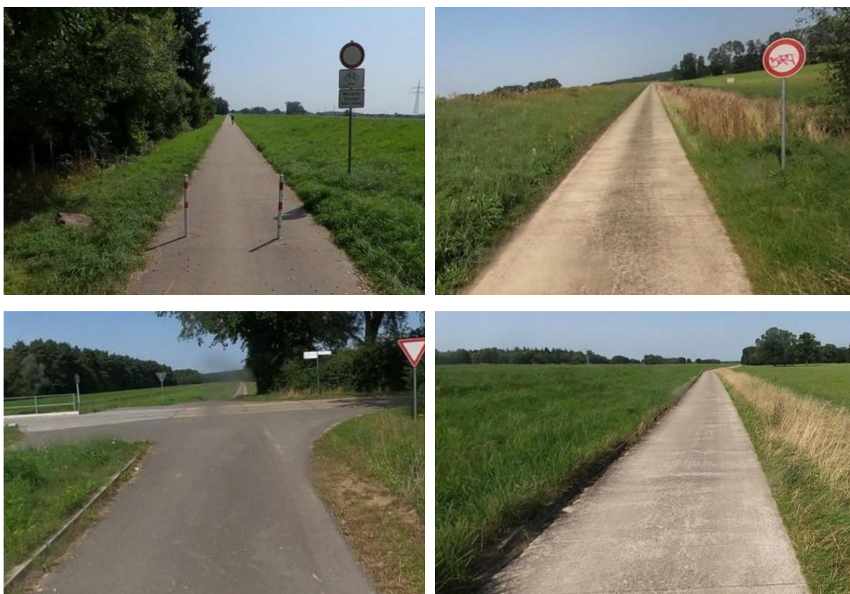
Abbildung 63: Bilder zur Bestandssituation entlang der Deichwegverbindung
