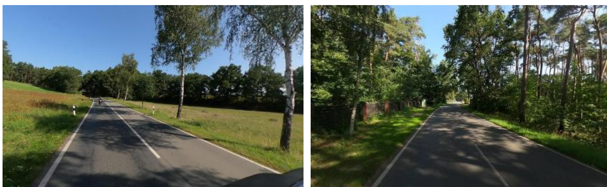
Abbildung 69: Bilder zur Bestandssituation entlang der L 261
