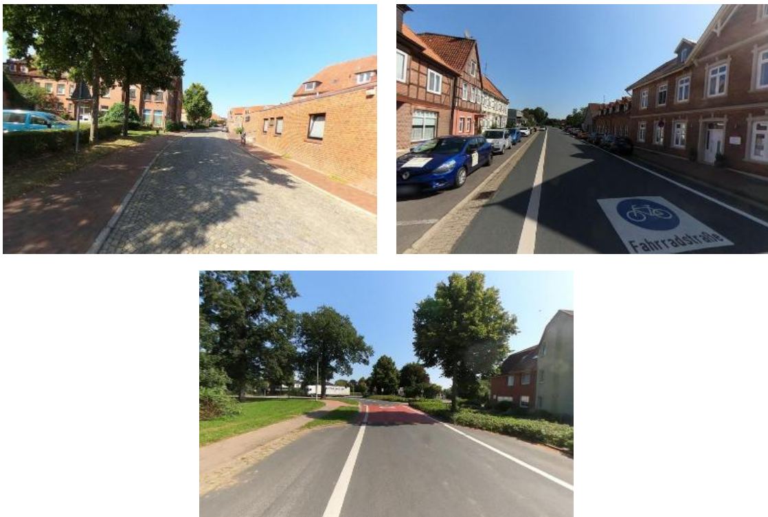
Abbildung 76: Bilder zur Bestandssituation entlang von Lindenweg und Marschtorstraße
